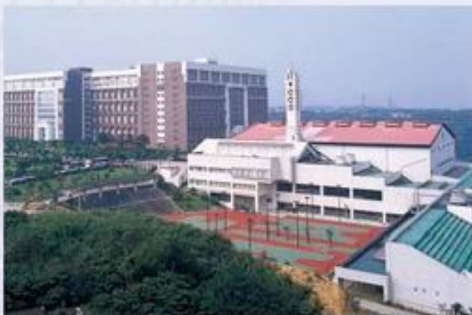
▲ 建築工程 Construction engineering
