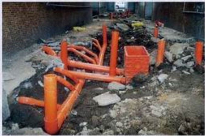
▲ 下水道工程 Sewer Engineering
